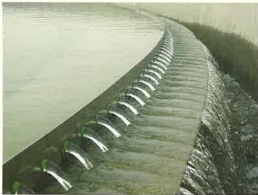
工業用水施設と廃水処理施設
