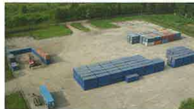
コンテナ・ヤード
