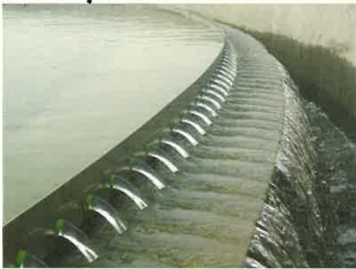
工業用水施設と廃水処理施設
