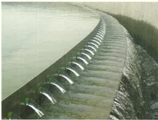
工業用水施設と廃水処理施設
